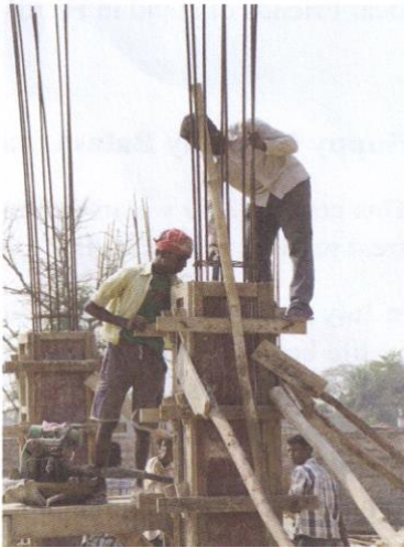
bouw van de kliniek in Jagatpur
