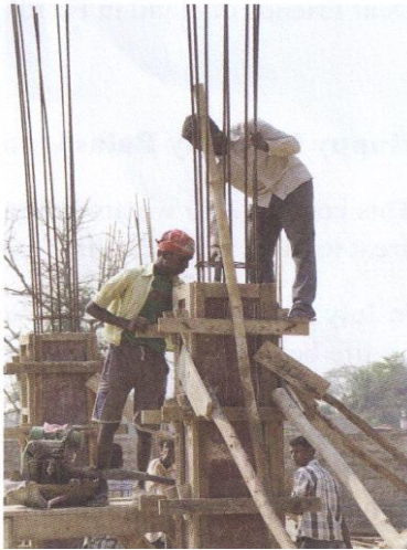
bouw van de kliniek in Jagatpur
