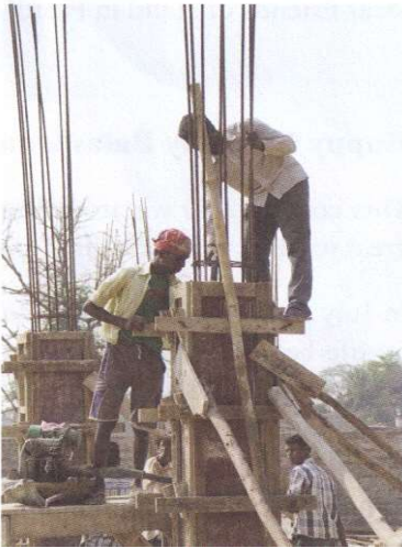
bouw van de kliniek in Jagatpur
