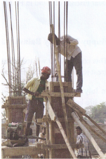
Bouw van het ziekenhuis in Jagatpur
